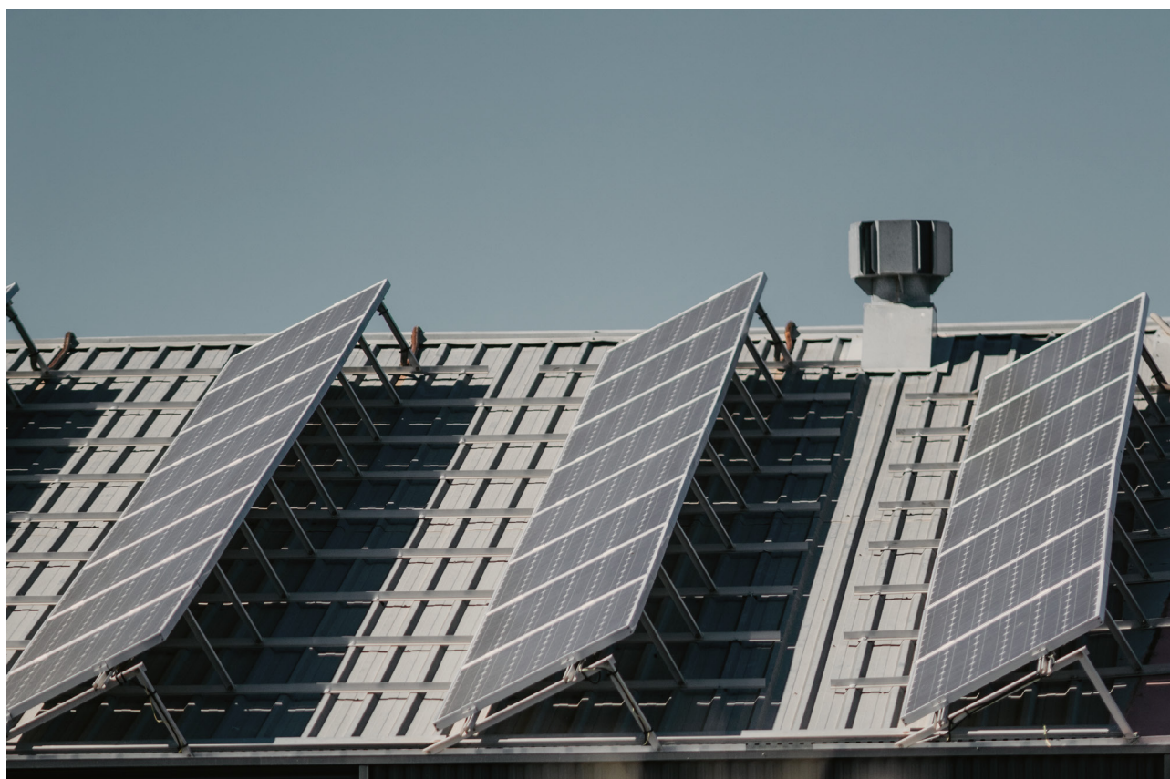
Instalación de placas solares en las oficinas centrales de Importaco en Beniparrell.
